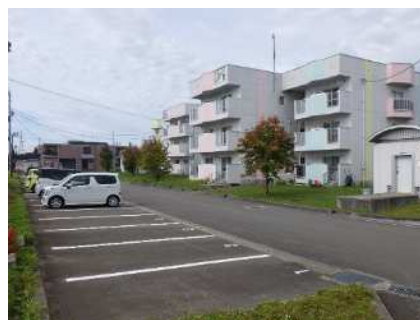
緑町団地（駐車場）
